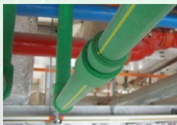
Tubería Faser no necesita aislación adicional para evitar efectos de condensación.
